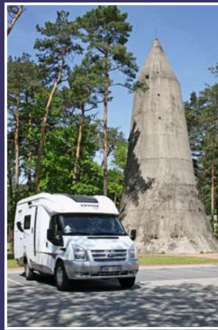
Hochbunker gehören in Wünsdorf zum Ortsbild.
