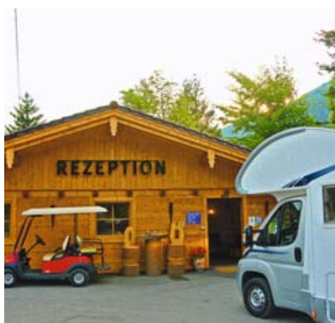
Neuer Stellplatz in Berchtesgaden S. 17
