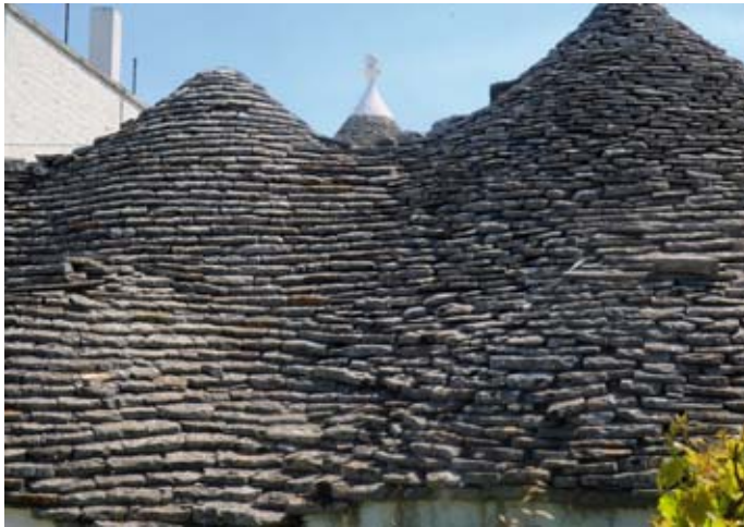
Die Detailaufnahme zeigt, wie die Dächer aus Bruchstein aufgeschichtet sind.
