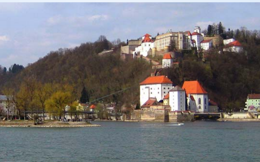
Passau: der Blick über die Donau auf die Veste Oberhaus
