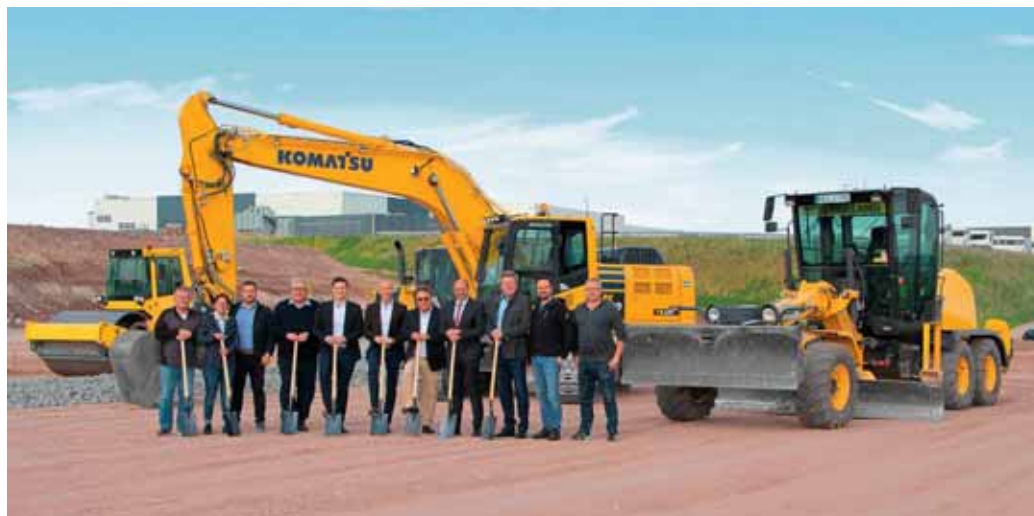
Der Spatenstich ist vollzogen: Bei Morelo in Schlüsselfeld entsteht ein Stellplatz für 52 Mobile.
